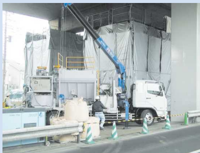
耐震補強工事(橋脚)
