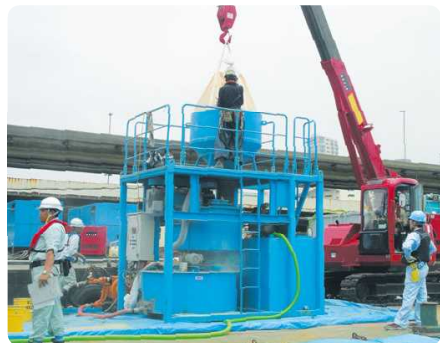
水中橋脚補強工事
