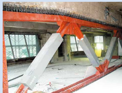
耐震補強工事(建築)
