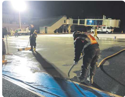
半たわみ舗装
