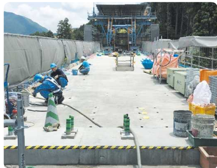
PC床版設置工事
