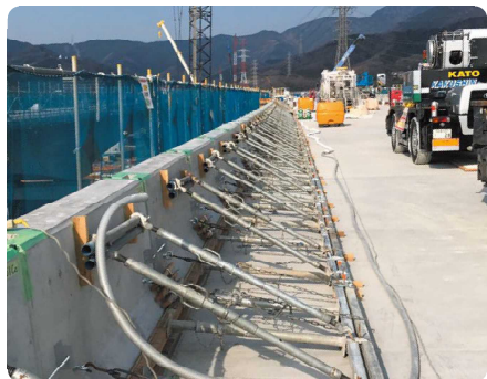
Pca高欄設置工事
