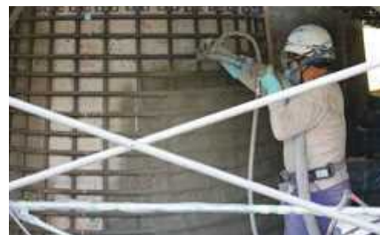
橋脚鉄筋増設工事
