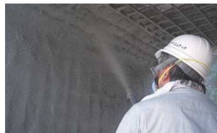
床版補強工事
